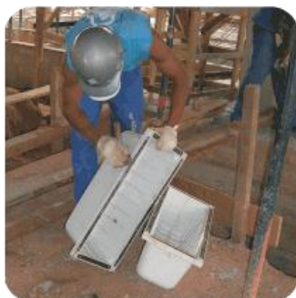
Fig. 05 Limpeza das FormPlast antes da reutilização
