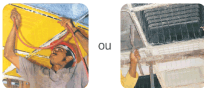
Fig. 04 Desforma com ar-comprimido ou ferramenta especial
